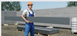
Produkte bei der Montage immer hochkant tragen.
