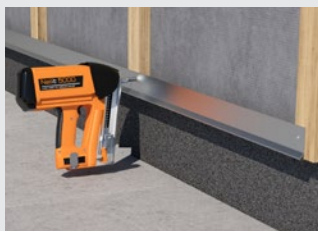
Befestigung des Sockel-Lüftungsprofil.
